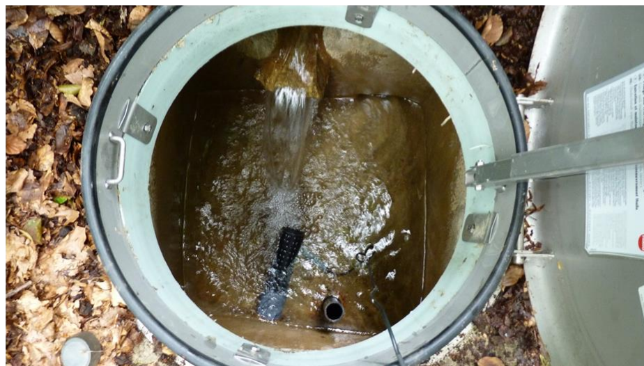
Figure 6 : Captage des Bernières (a et b : vue de l'intérieur du captage, la sortie d'eau est située en b à environ 1,50 mètres du fond, c : porte ouverte du captage avec cadenas, d : vue du captage avec l'arrivée d'eau en haut, la conduite de sortie avec crépine en bas à gauche et le trop-plein/vidange en bas à droite)
